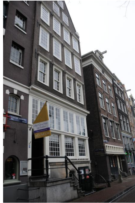
図2) 「屋根裏教会」博物館（手前）と計画対象地に建つ既存建物（路地を挟んだ奥）
